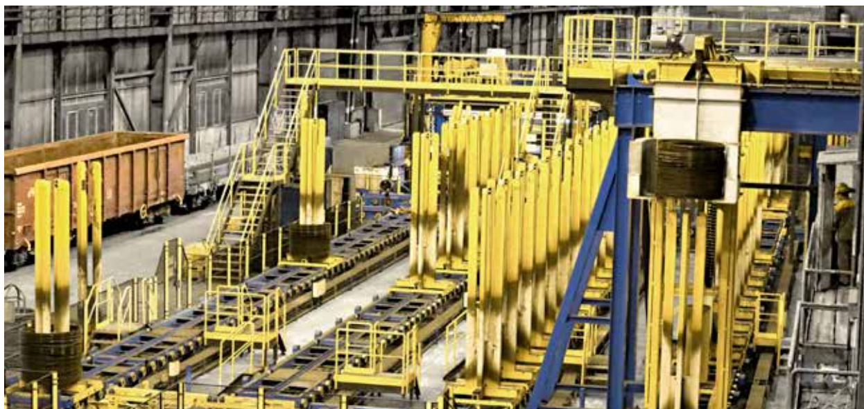
Neues Coil-Handling bei Swiss Steel am Standort Emmenbrücke, Schweiz
